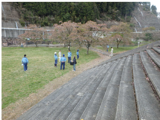
長瀬河川親水公園点検状況
