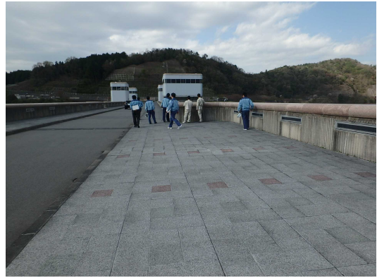
ダム天端歩道点検状況
