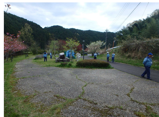
下流親水公園点検状況
